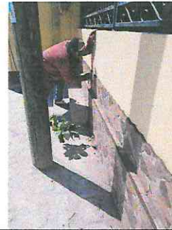
Foto 6: Instalación de piso cerámico (fachaleta)
