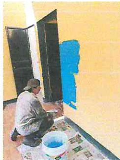
Foto 5: Pintura interior y exterior de la escuela
