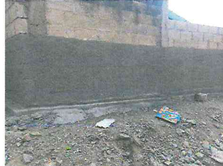
Foto 2: Recubrimiento y repello de muro perimetral
